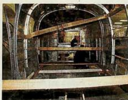
In Wakendorf II werden die Wohnwagen völlig entkernt. Nur die Hülle bleibt.
